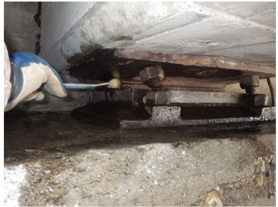
支承部への塗装
