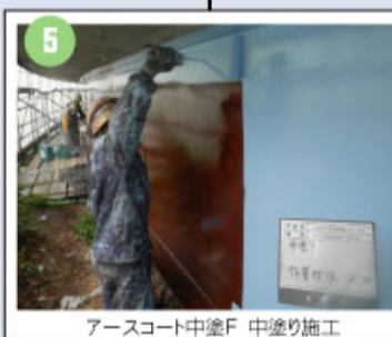
アースコート中塗F 中塗り施工
