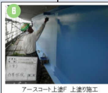
アースコート上塗F 上塗り施工
