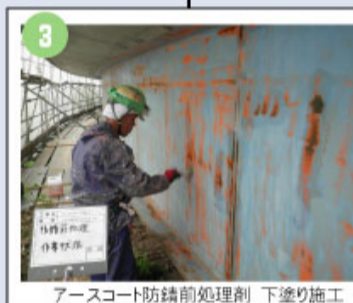
アースコート防錆前処理剤 下塗り施工
