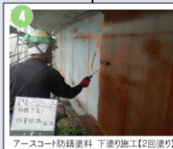
アースコート防錆塗料 下塗り施工【2回塗り】
